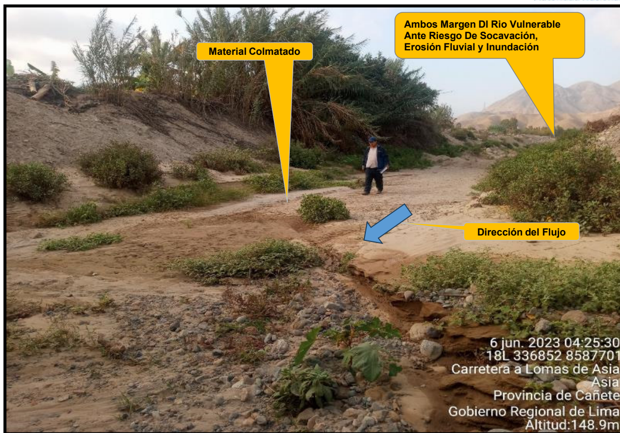
FIGURA N°04: AREA COLMATADA EN EL TRAMO CRITICO DEL RIO GRANDE DE ASIA OMAS, PRODUCIDO EN LAS MAXIMAS AVENIDAS DE AGUA
