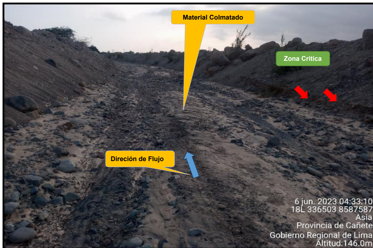
FIGURA N°05: SE MUESTRA LA SOCAVACION QUE PRODUCE EL RIO GRANDE DE ASIA OMAS EN AVENIDAS DE HUAYCO, PRODUCIDO POR EL CICLON YAKU
