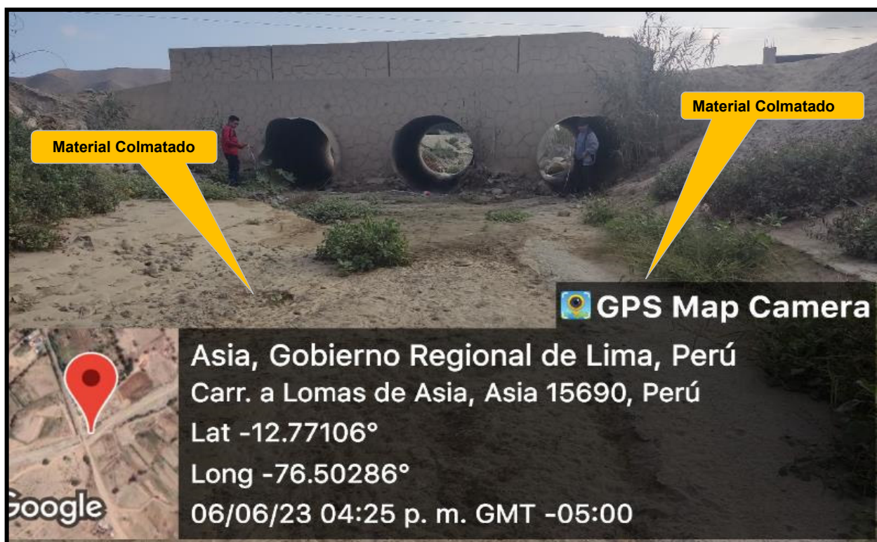
FIGURA N°03: EN LA TEMPORADA DE MAXIMAS AVENIDAS, EL RÍO GRANDE DE ASIA OMAS, SE COLMATA DE MATERIALES EN EL TRAMO DEL PUENTE TIPO ALCANTARILLA DE LA CARRETERA DE LOMAS DE ASIA, QUE SE
